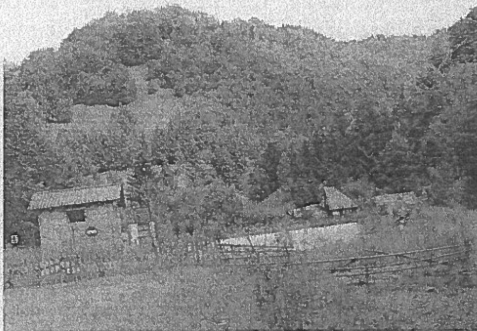
Fig. 10. Gospodărie permanentă situată în imediata proximitate a captării (partea dreaptă a fotografiei).
