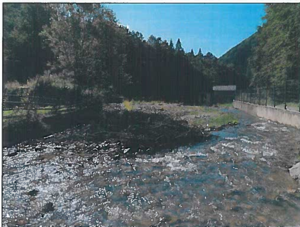
Fig. 16 – Aspecte din stația T2
