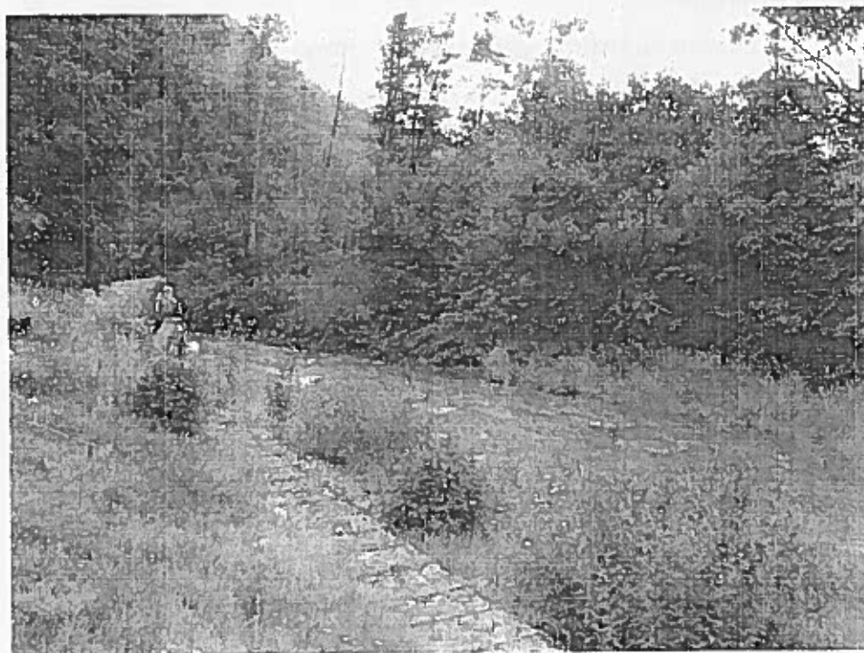
Foto 1.22. Stația Taia 5 aspect general (se observă gabioanele de pe malul stâng)
