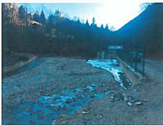
Fig. 157 Detaliu amonte captare Taia
