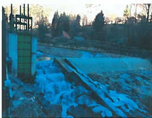
Fig. 158 Detaliu captare Taia
