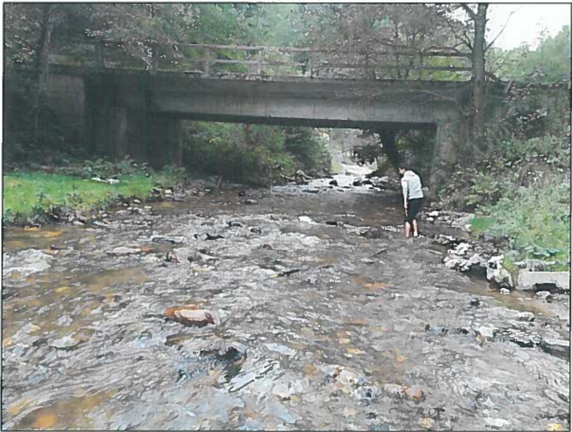
Fig. 20 – Aspecte din stația T7
