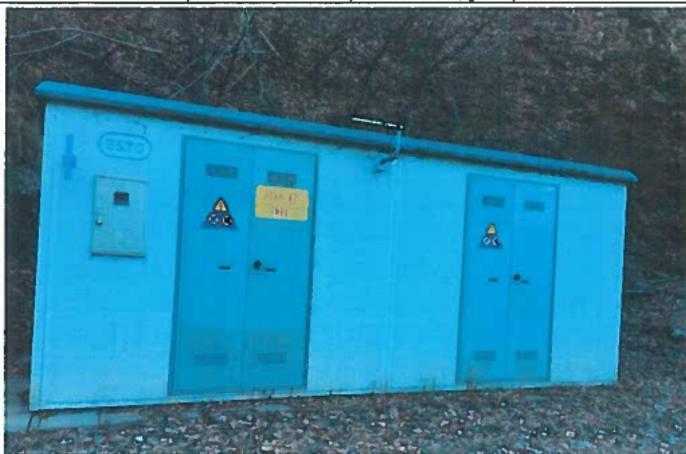
Fig. 156 Detaliu compartiment de racordare (partea stângă compartimentul ENEL DISTRIBUȚIE BANAT S.A., iar în partea dreaptă compartimentul producătorului)
