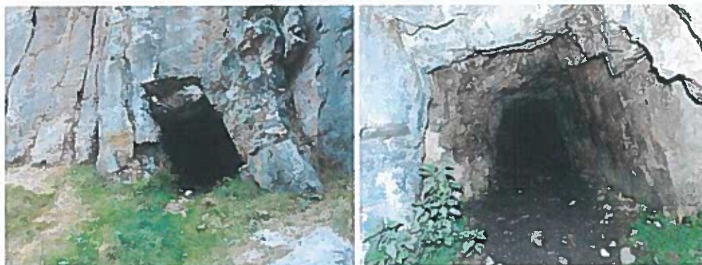
Fig. 27 Detalii galeria artificială nr. 1
