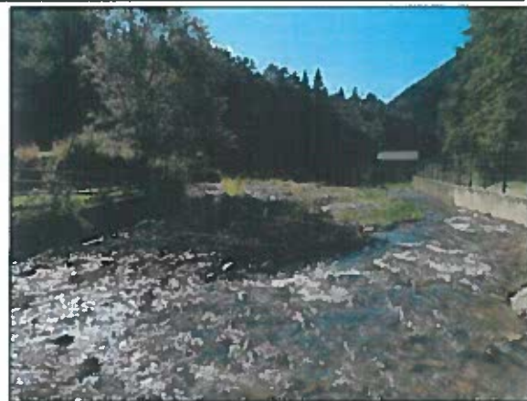
Aspecte din stația T2
