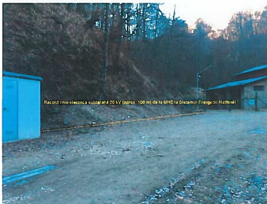
Fig. 155 Racord linie electrică subterană 20 kV (aprox. 100 m) de la MHC la Sistemul Energetic Național
